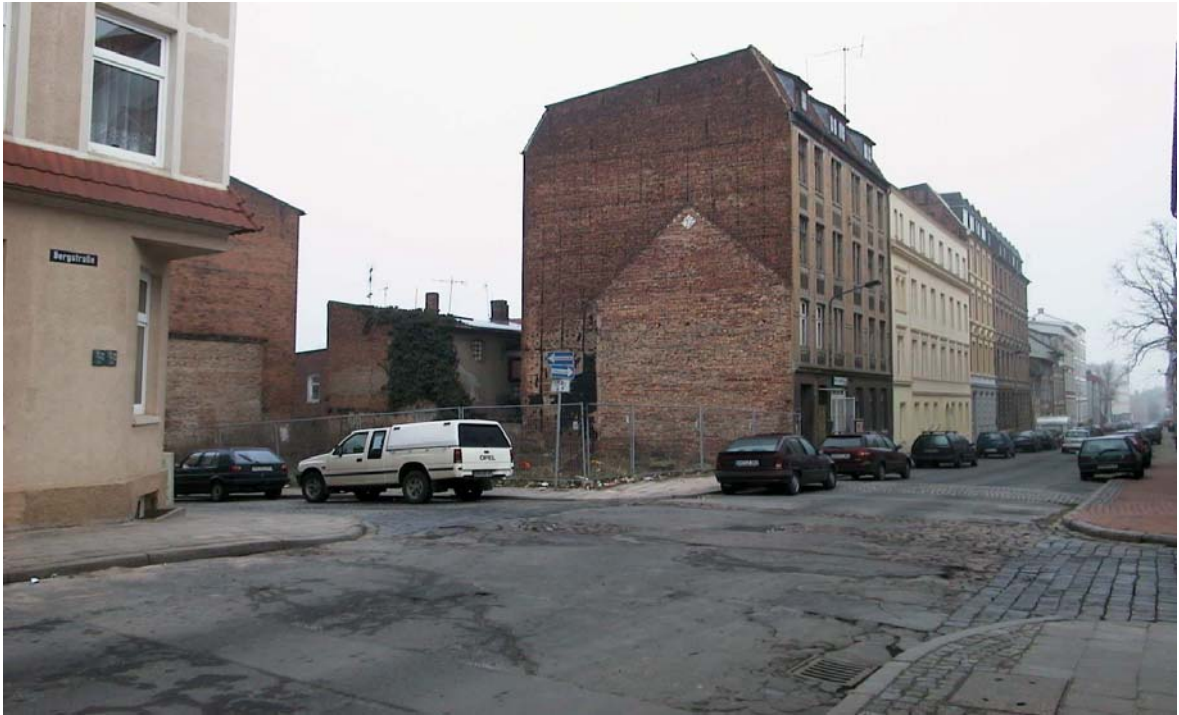
Straßenzustand Bergstraße / Ecke Landreiterstraße
