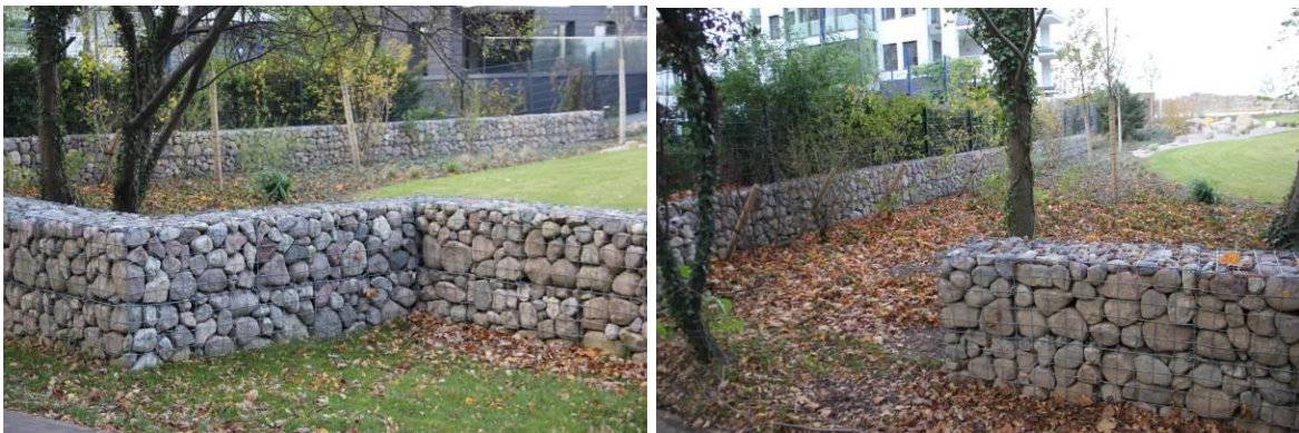
Bsp. Ökologische Trockenmauer in Form von Gabionen
