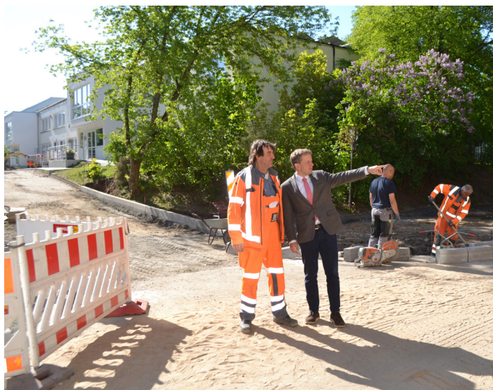
Sanierungsarbeiten in der Erich-Weinert-Straße: OB Rico Badenschier im Gespräch mit Frank Grätcher von der Firma KEMNA Schwerin Tief- und Straßenbau GmbH aus Conrade. © Landeshauptstadt Schwerin/Mareike Diestel
