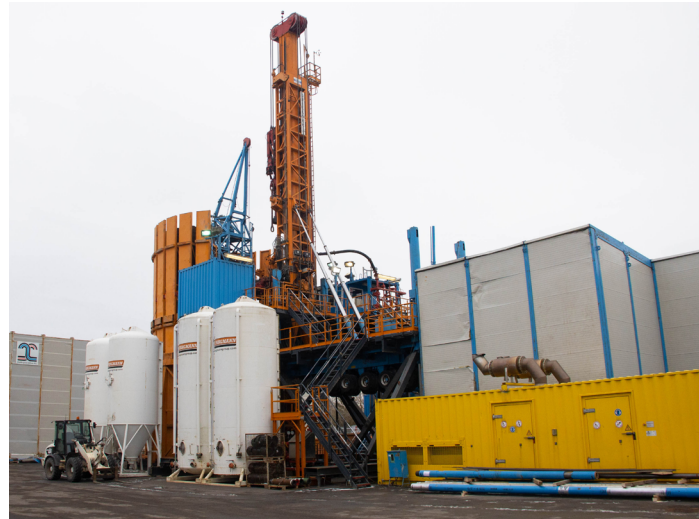
Der Bohrturm in Lankow.
