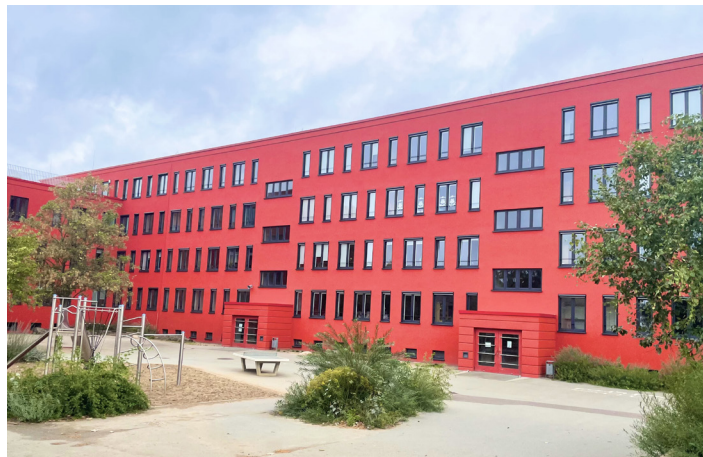
Nach zwei Jahren sind die Sanierungsarbeiten an der Astrid-Lindgren-Schule abgeschlossen. © Landeshauptstadt Schwerin/Mareike Diestel
